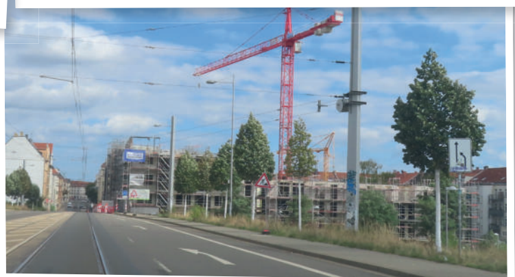
Wie in anderen Stadtteilen werden auch an der Antonienstraße Neubauwohnungen im Stadtteil Kleinzschocher errichtet
